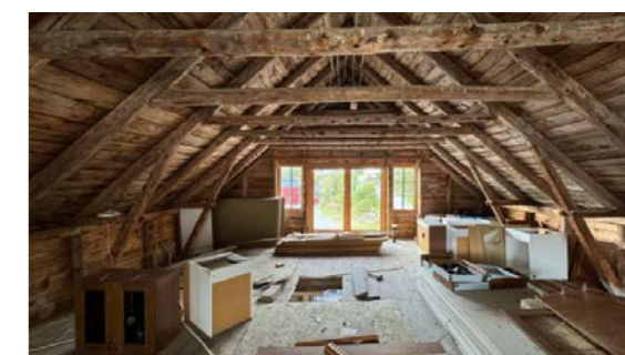
Oversiktsbilde av loft/takkonstruksjon.
