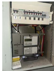
Sikringsskap med automatsikringer.
