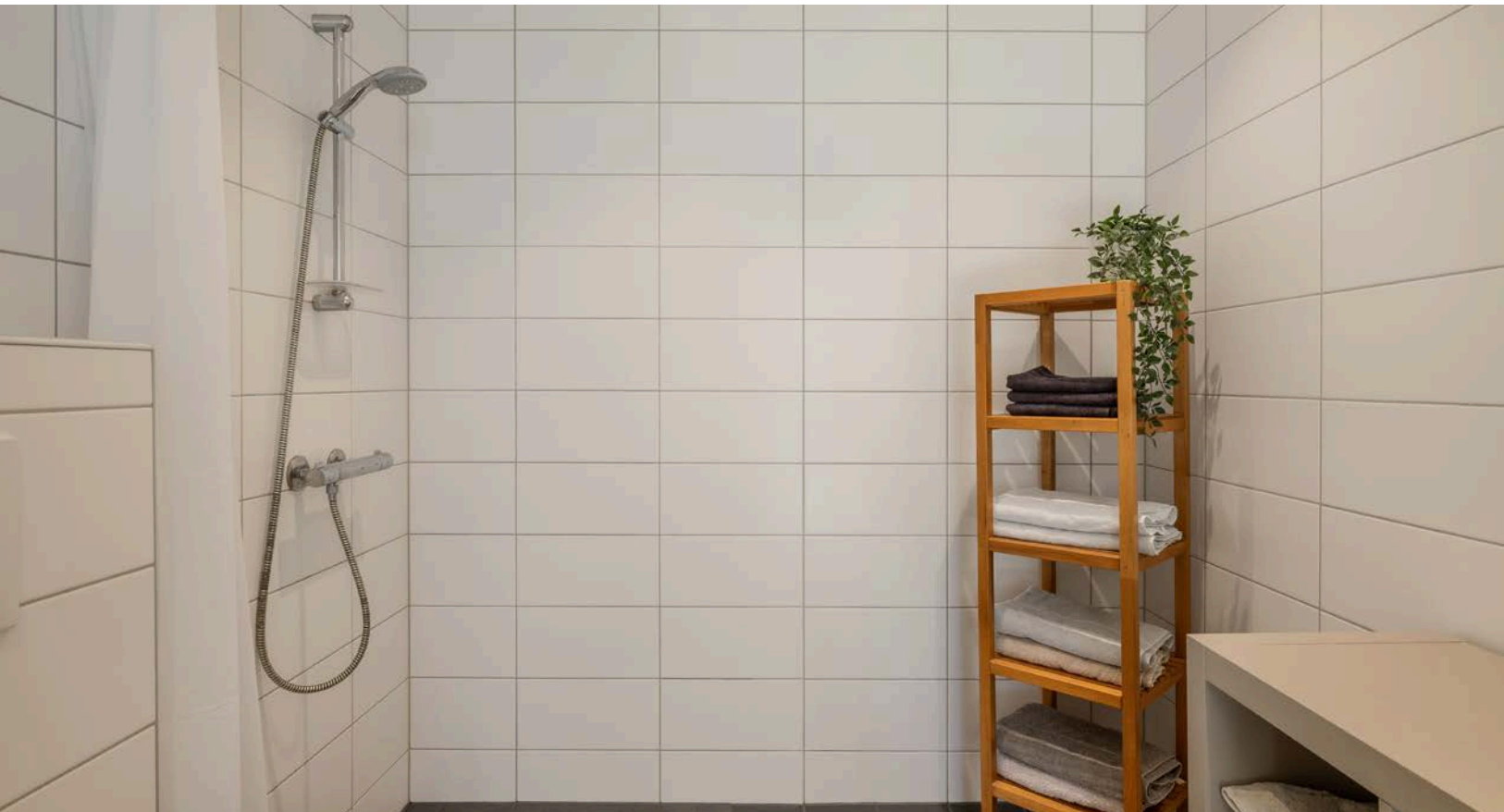
Dusjnise med veggmontert dusjbatteri og montert stang for forheng. Her er det klargjort for innsetting av badekar om man skulle ønske dette.
