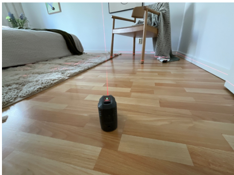
Nivellering soverom, avvik ca. 10-20 mm
