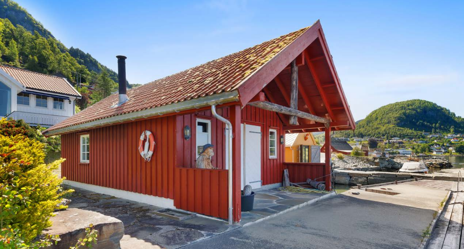
Sjøhuset er totalrenovert i perioden 2006-2009, har innlagt strø,
