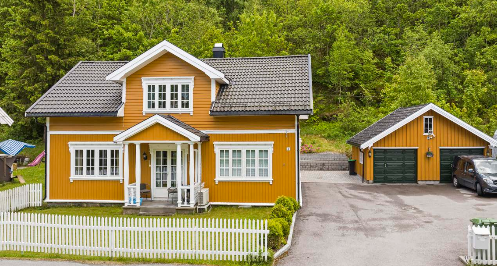
Innbydende inngangsparti med stor, asfaltert gårdsplass og belegningsstein ved inngangsparti.
