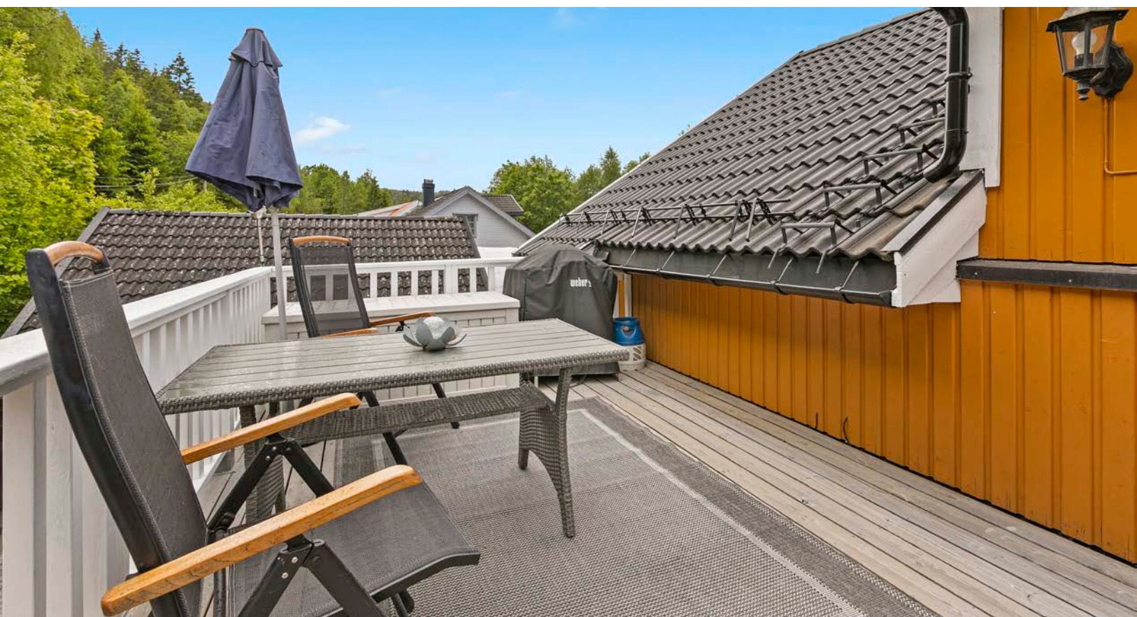
Del av balkong i 2. etg.
