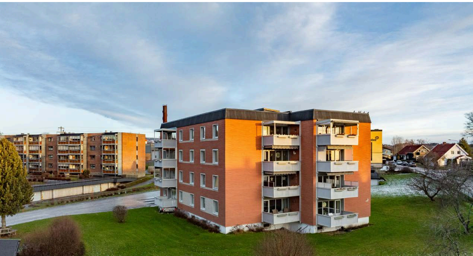
Fellesarealer er opparbeidet med gressplen, diverse beplantning og sittegrupper. Asfalterte internveger og parkeringsarealer.
