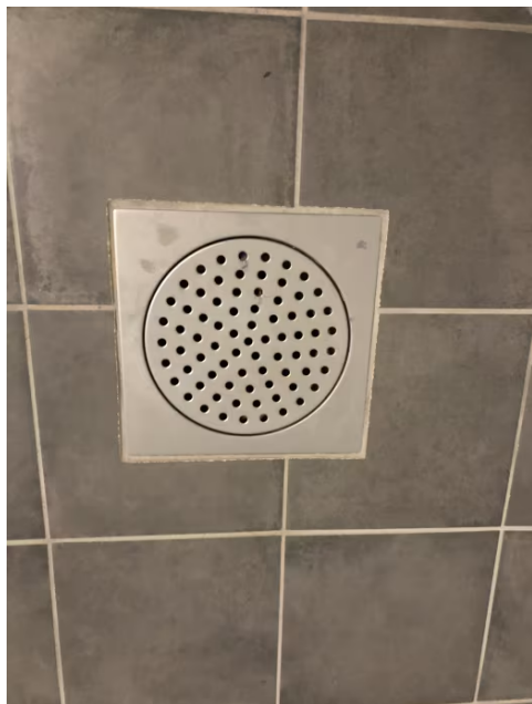
Det er smøremembran tilsluttet plastsluk med klemring
