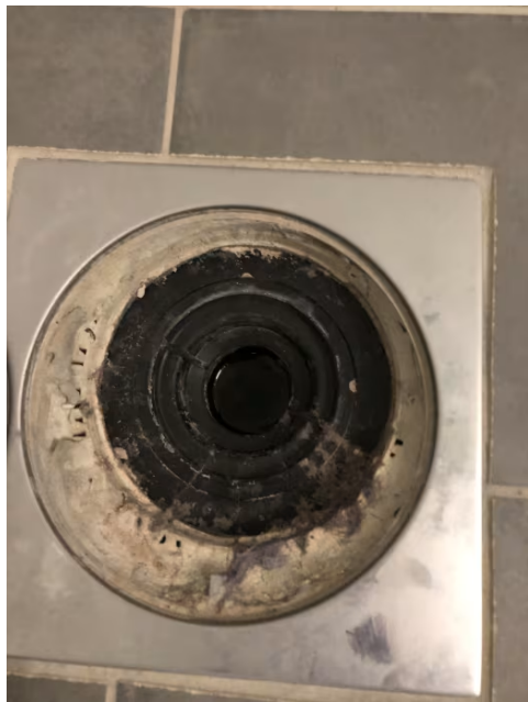
Det er smøremembran tilsluttet plastsluk med klemring
