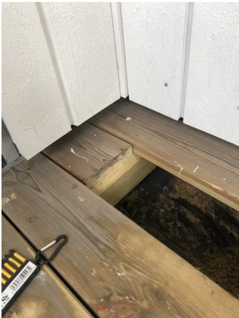
Det er etablert inspeksjonsluke over sluken i balkonggulvet
