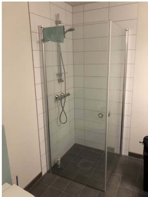
Bad har fliser på gulv og i dusjsonen.
