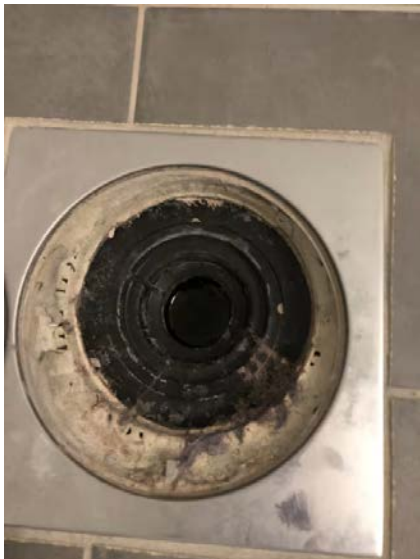
Det er smøremembran tilsluttet plastsluk med klemring
