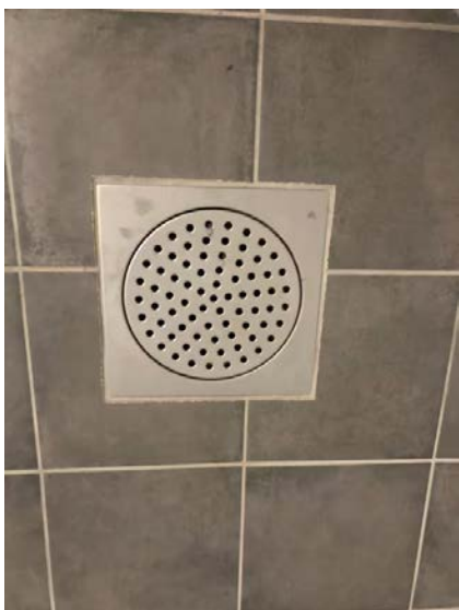
Det er smøremembran tilsluttet plastsluk med klemring
