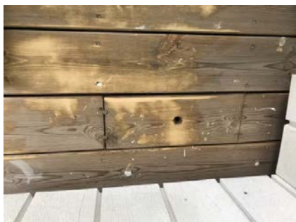
Det er etablert inspeksjonsluke over sluken i balkonggulvet
