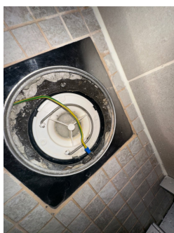
Plastsluk med klemring for membran
