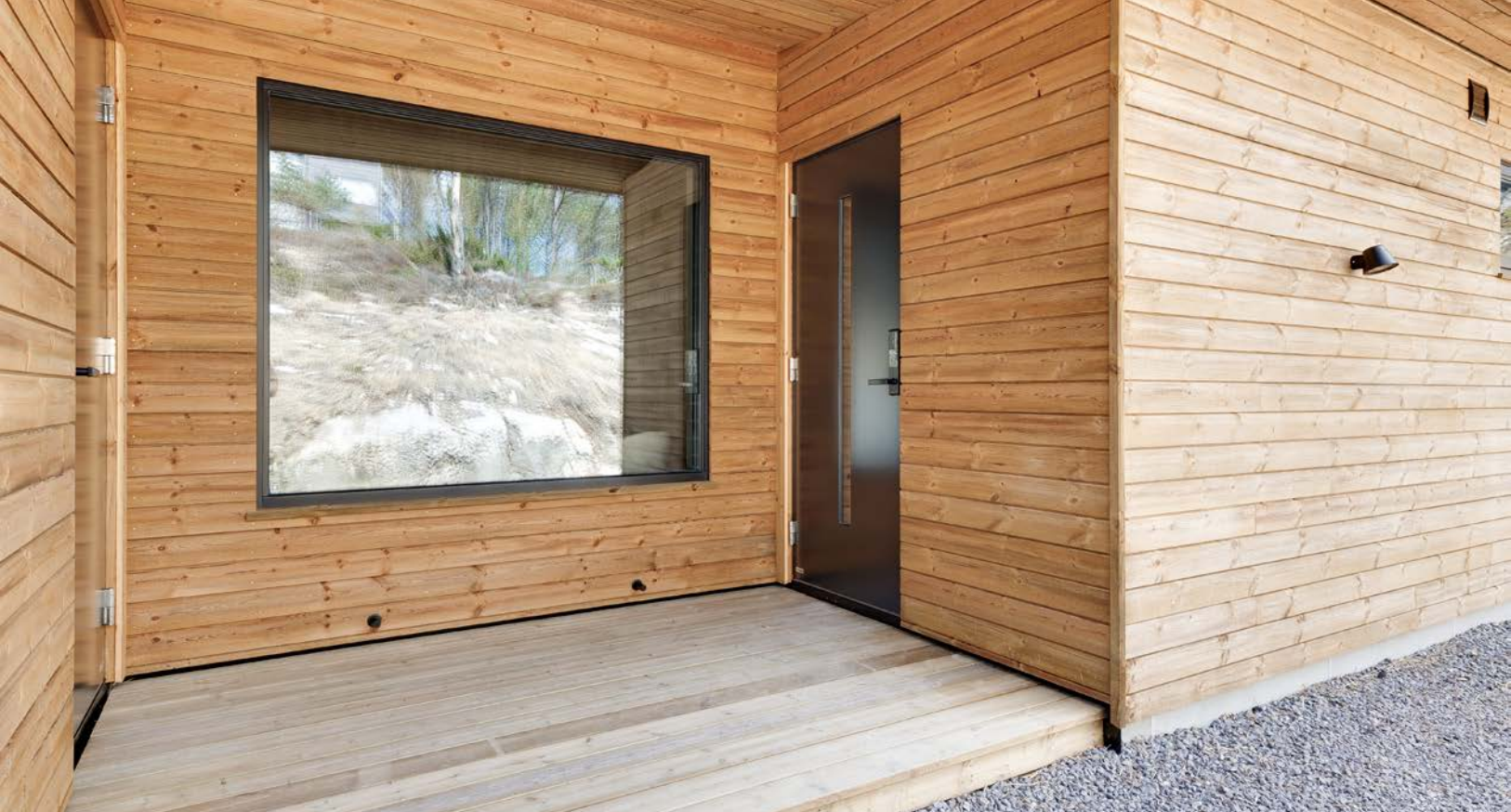
Takoverbygg ved inngangsparti og bod - begge dører med kodelås.
