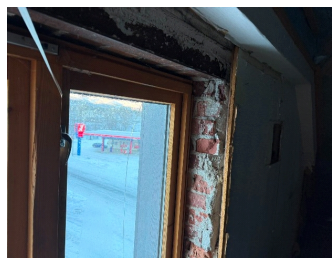
Murt teglvegg opp til loft
