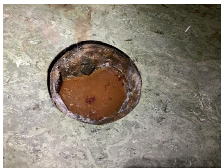
Utett tilslutning rundt sluk.
