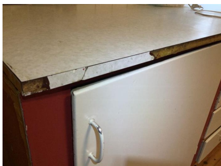
Skadet og løsnet kantlist fra benkeplate.
