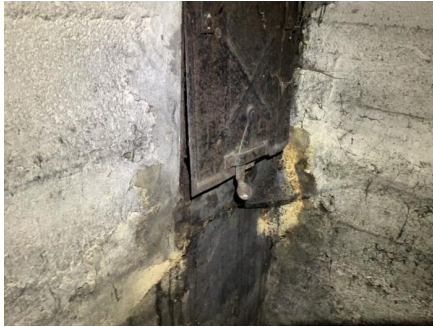
Rustskadet sotluke i kjeller.
