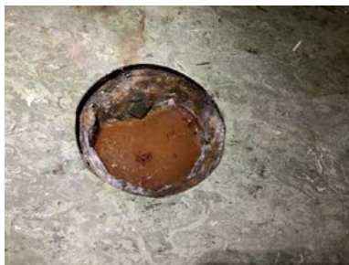
Utett tilslutning rundt sluk.
