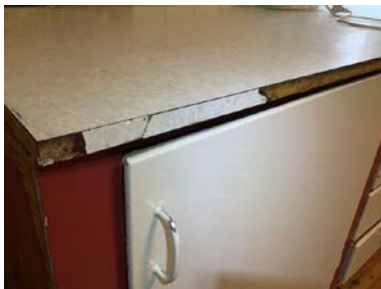
Skadet og løsnet kantlist fra benkeplate.
