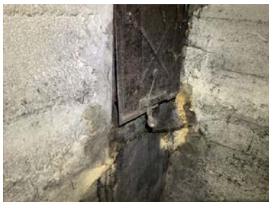
Rustskadet sotluke i kjeller.
