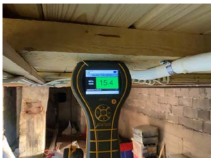
Fuktmåling i bjelker.
