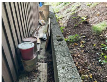
Forstøtningsmur bak garasjen.
