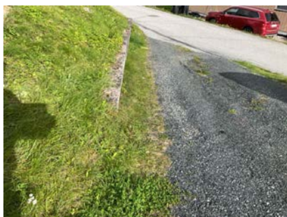
Forstøtningsmur mot adkomst.
