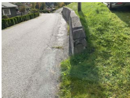
Forstøtningsmur mot vei.
