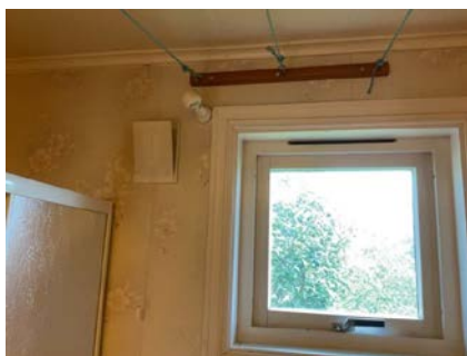
Naturlig lufting i vegg.
