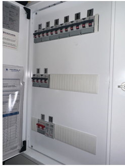
Sikringskap med automatsikringer.
