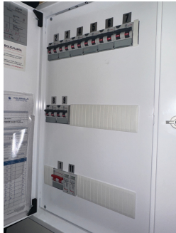
Sikringskap med automatsikringer.
