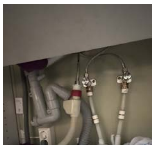
Rørapplegg i kjøkkenbenk med Waterguard
