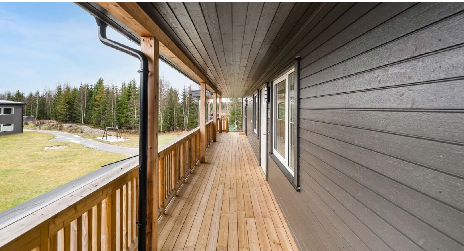
Overbygget svalgang ved inngangsparti.
