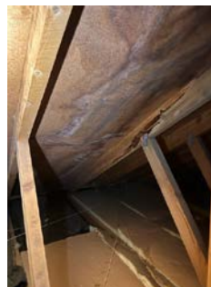
Fuktmerker nedenfor pipe på loft.
