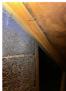
Fuktmerker nedenfor pipe på loft.
