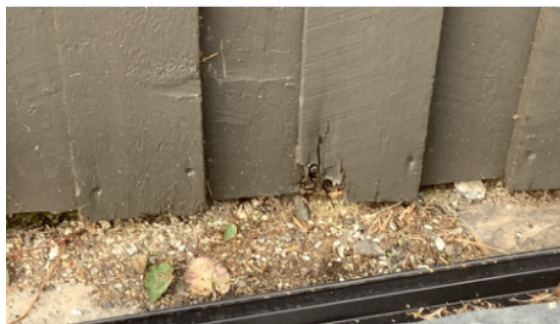
Råteskadet kledning.
