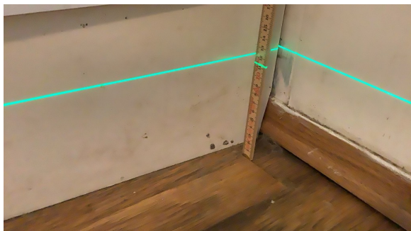
90 mm høydeforskjell i påbygg.
