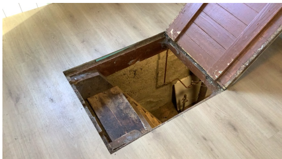
Tilgang til kjeller og deler av kryprom fra luke i gulv.
