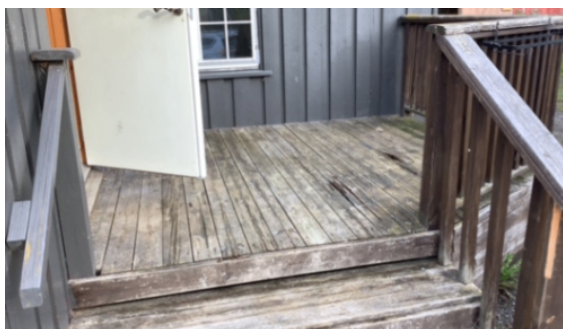
Terrasseplattening foran inngang.
