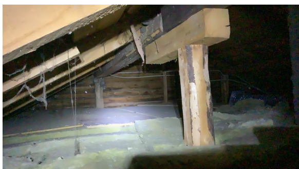
Viser møneloft over opprinnelig hus. Tilbyggene har ikke tilgang til loft.
