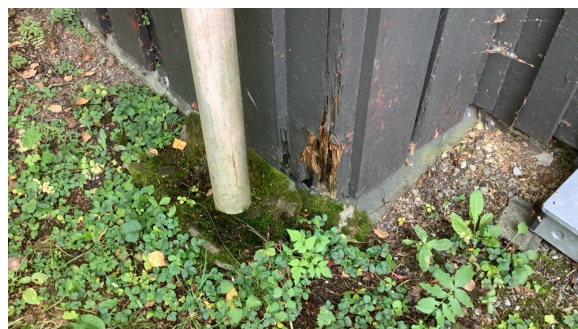
Råteskadet kledning.
