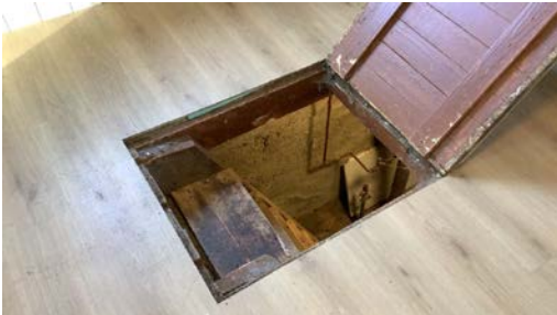
Tilgang til kjeller og deler av krypprom fra luke i gulv.
