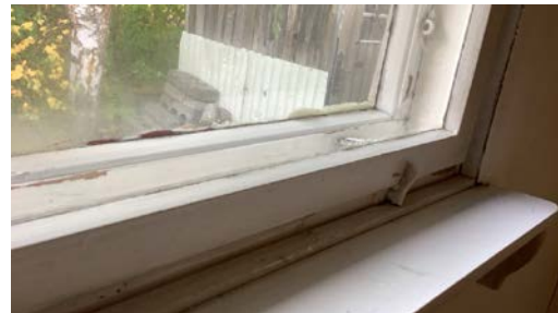
Enkelte vinduer fra byggeår.
