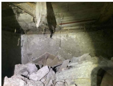
Bilde av mur fra innside.
