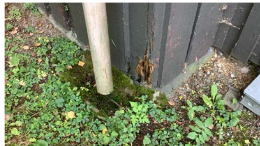
Råteskadet kledning.
