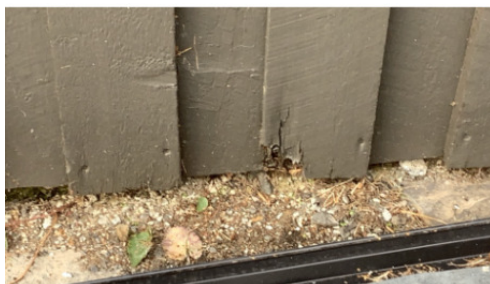
Råteskadet kledning.
