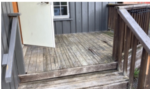
Terrasseplattning foran inngang.
