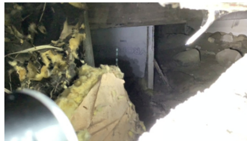
Bilde fra åpning i mur under bad. ikke tilgang.
