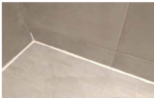
Bilde av mykfugen i dusjsonen
