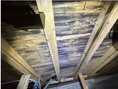
Bilde viser underside av bjelkelag/gulv i 1. etasje sett fra krypkjeller.
