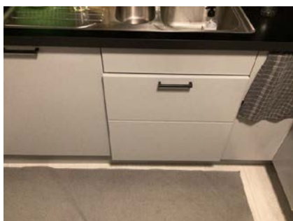
Hindring i å lukke underskap.
