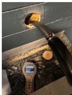
Fuktmåling i vegg mot våtsone
