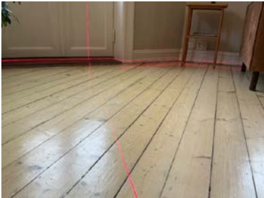
Etasjeskiller er kontrollert med krysslaser.
