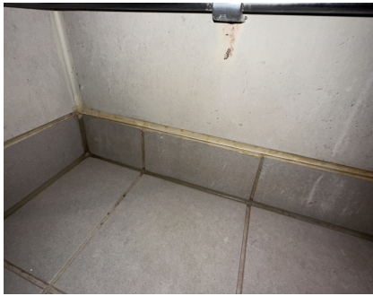
Silikon mellom baderomsplate og flis
