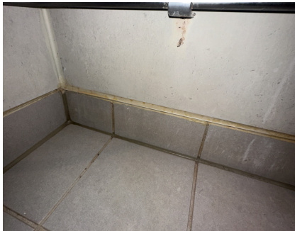
Silikon mellom baderomsplate og flis
