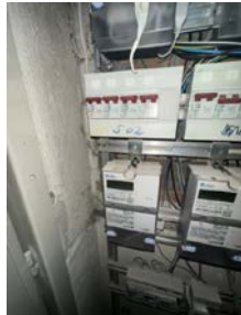
Sikringsskap med automatsikringer.
