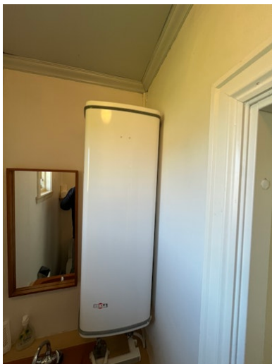
Bereder med ukjent alder i 2 etasje.
