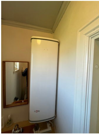
Bereider med ukjent alder i 2 etasje.
