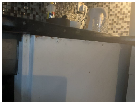
Skader på fronter.
