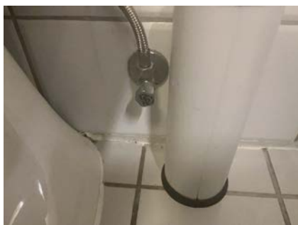
Noe dårlige fuger mellom gulv og vegg.
