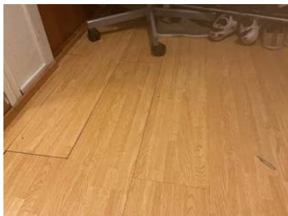
Merker på gulv. Laminatbord som har åpninger mellom.
