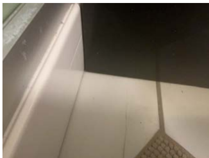
Noe dårlige fuger mellom gulv og vegg.
