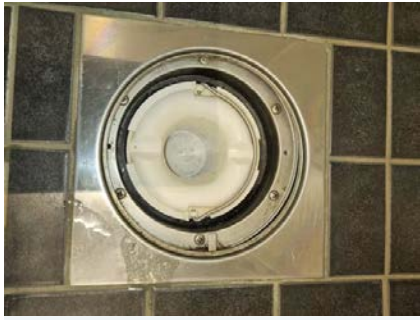
Bilde viser sluk på bad.
