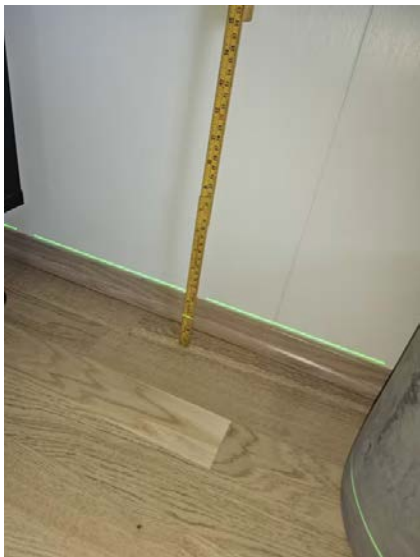
Bilde viser måling av etasjeskiller.
