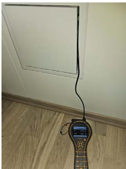
Bilde viser fuktmåling i inspeksjonsluke.
