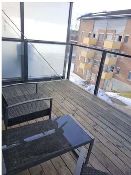
Bilde viser balkong.
