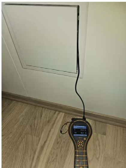
Bilde viser fuktmåling i inspeksjonsluke.
