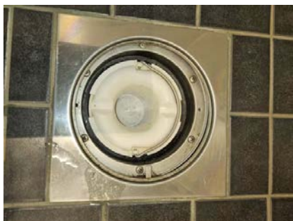
Bilde viser sluk på bad.
