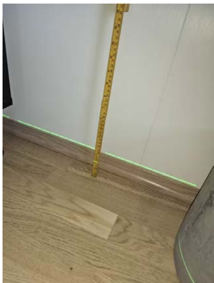
Bilde viser måling av etasjeskiller.
