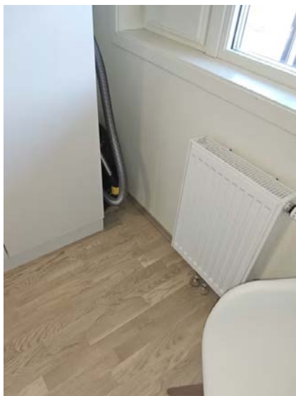
Bilde viser radiator på soverom.
