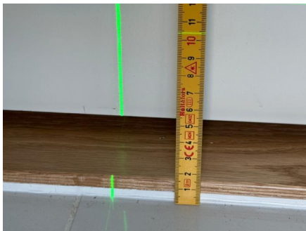
Fallforhold ca. 104 mm overkant gulv ved terskel
