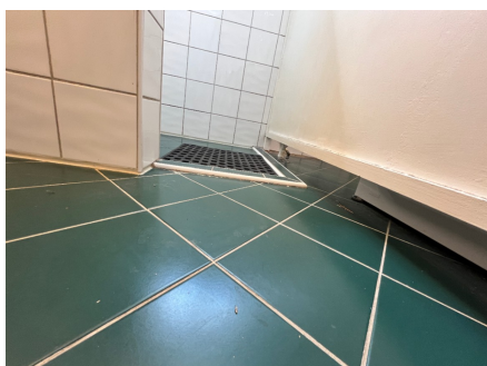
Forhøyning ved dusjnisje.
