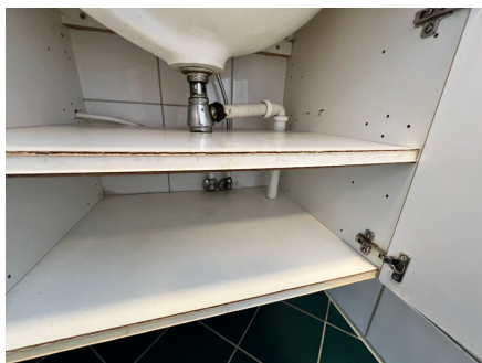
Fuktsvelling på skapskrog
