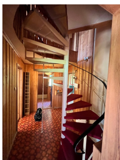
Lavt rekkverk og store åpninger i rekkverk
