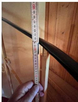
Lavt rekkverk og store åpninger i rekkverk
