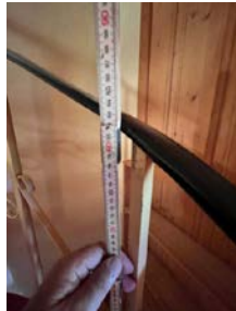
Lavt rekkverk og store åpninger i rekkverk
