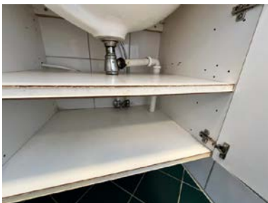
Fuktsvelling på skapskrog
