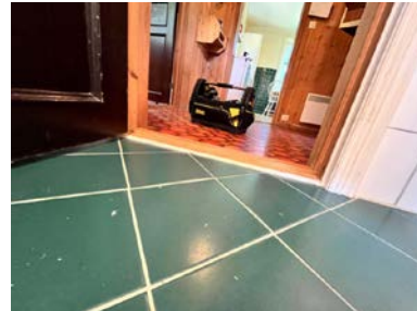
Oppkant under dør.
