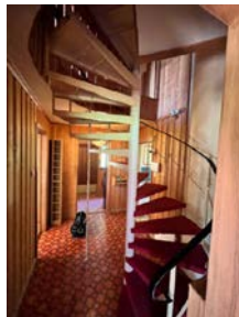
Lavt rekkverk og store åpninger i rekkverk
