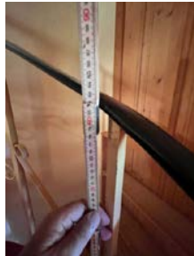
Lavt rekkverk og store åpninger i rekkverk
