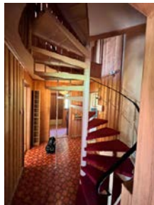
Lavt rekkverk og store åpninger i rekkverk
