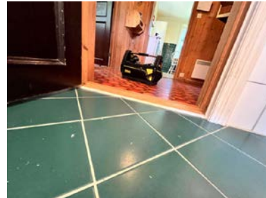
Oppkant under dør.
