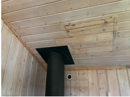
Hull etter gammel pipe er skjøtt i med panelbord.
