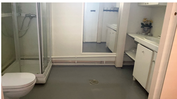
Oversiktsbilde av bad.
