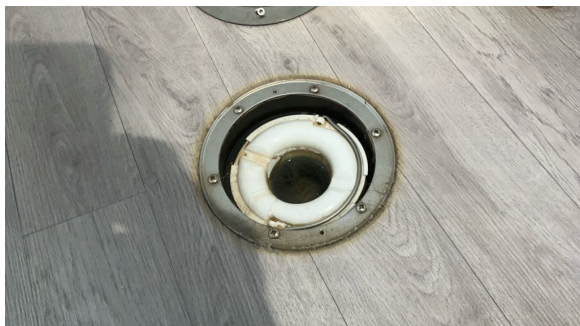
Kontroll av sluk.
