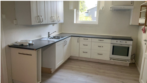
Oversiktsbilde av kjøkkenet.
