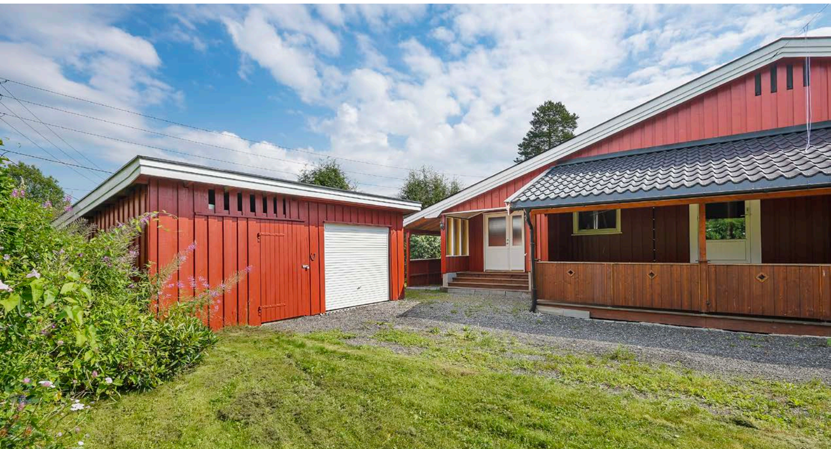
Garasje inntil boligen.
