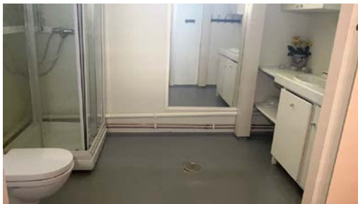
Oversiktsbilde av bad.
