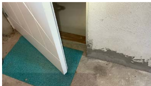
Kjellerdør trenger justering.
