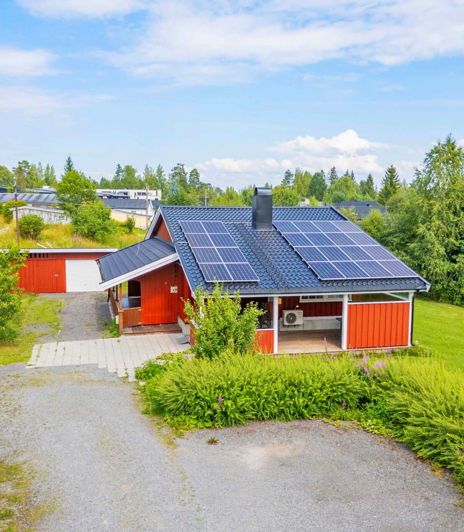
Solceller på taket.
