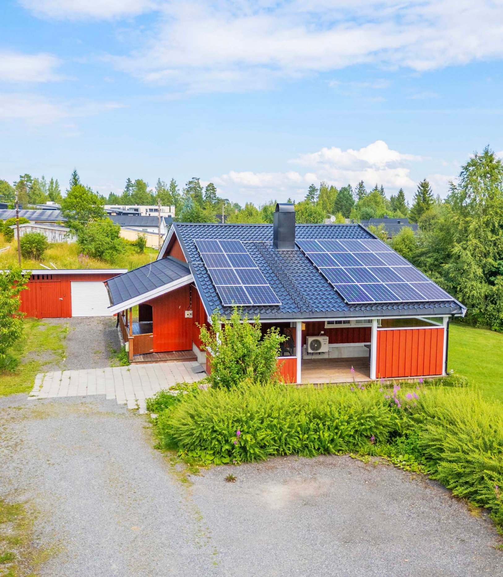
Solceller på taket.
