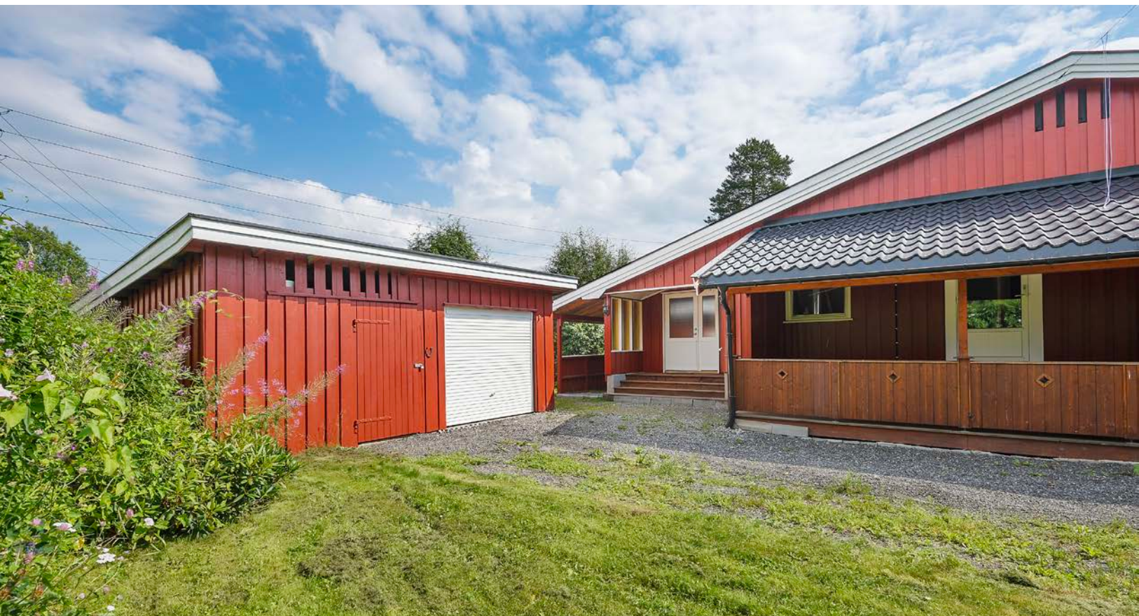
Garasje inntil boligen.
