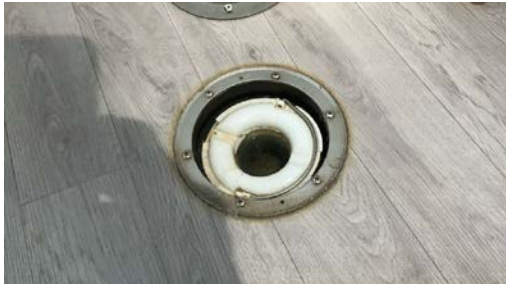
Kontroll av sluk.
