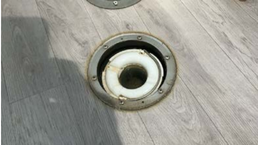
Kontroll av sluk.
