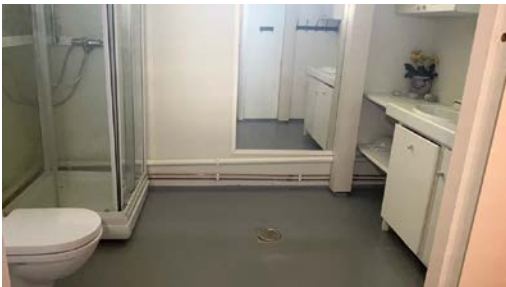
Oversiktsbilde av bad.
