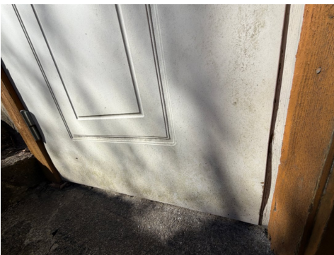
Noe "svelling" i overflater i dør til kjeller
