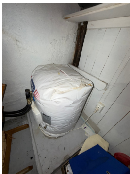
Bereder i hjørneskap på loft er ikke tilgjengelig.
