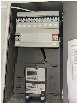
Sikringsskap med automatsikringer.
