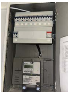
Sikringsskap med automatsikringer.
