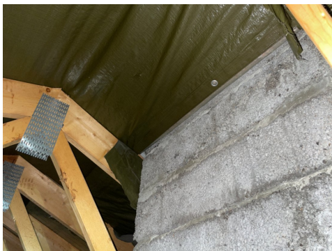
Undertak av presenning på tilbygget garasje.
