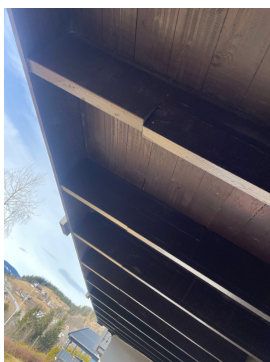
Skjøter i bjelker i lengderetning.
