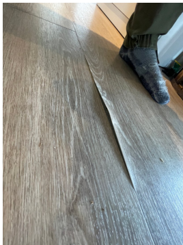
Løs vinylflis i gang utbedret av eier.
