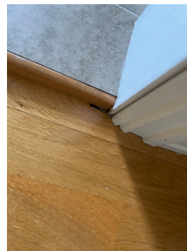
Stedvis synlige glipper mellom gulv og list
